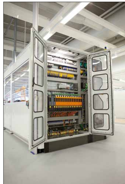
Obr. 2. Moduly X20 řídí montáž modulů X20; také další automatizační technika nese značku B&R, např. měniče AcoposInverter X64 a servopohony AcoposMulti
