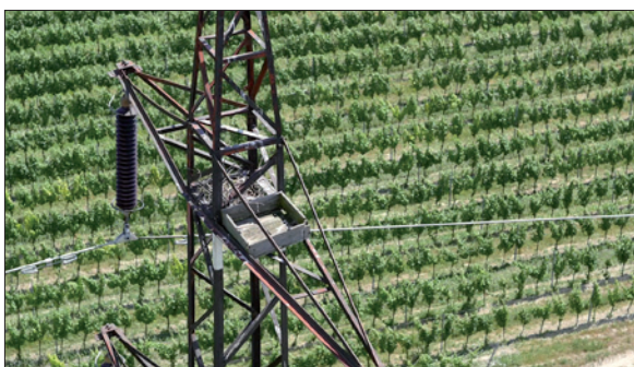
Obr. 1. Drony pomáhají při inspekci stožárů vvn
