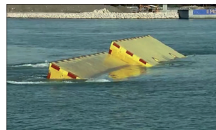
Obr. 2. Stavidla Mo.S.E. v ověřovací provozu v úžině Lido (zdroj: ABB)
