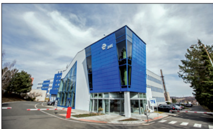
Obr. 1. Budova ZAT v Příbrami
