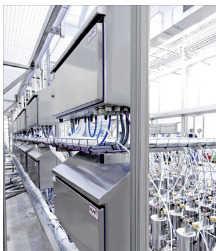
Obr. 1. Skříně řady HD (hygienický design) od společnosti Rittal jsou zkonstruovány speciálně s ohledem na potřeby potravinářských provozů
