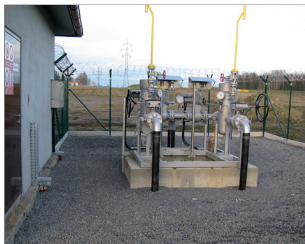
Obr. 4. Vstupní objekt předávací stanice
