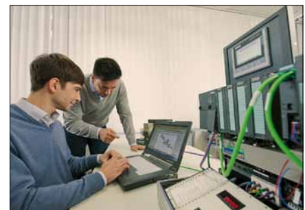
Obr. 4. Jedno ze školicích pracovišť Školícího střediska Siemens
