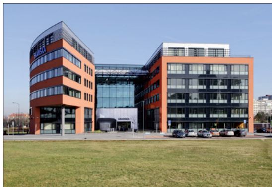
Obr. 1. Budova administrativního centra Opatov Park I poskytuje pracovníkům firmy Skanska téměř 15 000 m 2 kancelářských ploch
