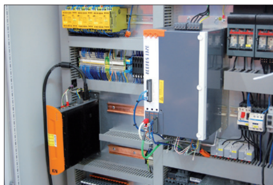
Obr. 1. Servopohon řady Acopos je s řídicím počítačem APC620 propojen sběrnici Powerlink
