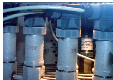
Obr. 3. Typová zkouška snímačů při teplotě -40 °C
