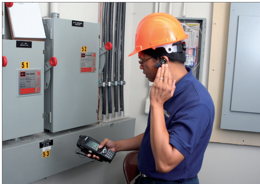
Obr. 3. Servisní technik načítá data pomocí techniky RFID
