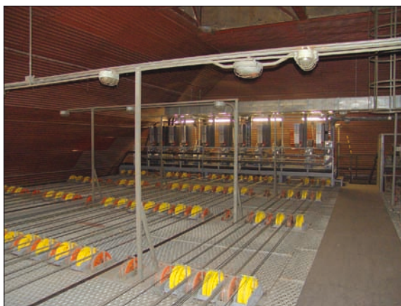
Obr. 2. Provaziště nad velkým jevištěm
