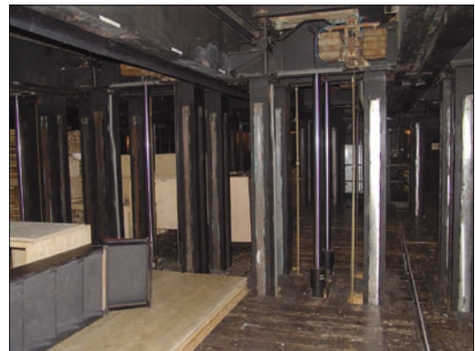
Obr. 5. Hydraulické pohony jevištních stolů
