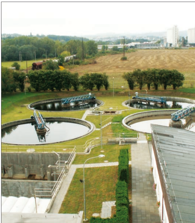
Obr. 3. Čistírnu odpadních vod Zábřeh na Moravě úspěšně řídí systémy řady Modicon
