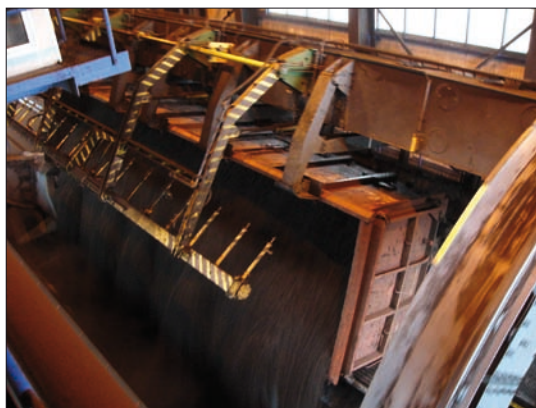
Obr. 5. Pohled na vyklápění vagonu z kabiny operátora
