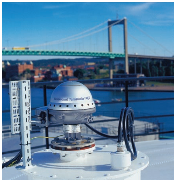
Obr. 1. Moderní měřidlo ATG současně zajišťuje také funkční bezpečnost nádrže
