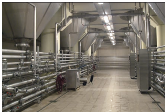
Obr. 4. Cylindrokónické tanky hlavního kvašení jsou vybaveny množstvím klapek a armatur
