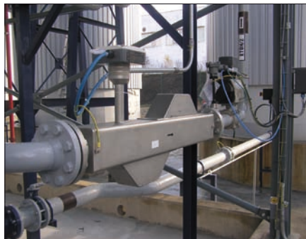
Obr. 3. Bilanční měření množství biolihu s použitím komponent značky Siemens (foto Chemoprag)
