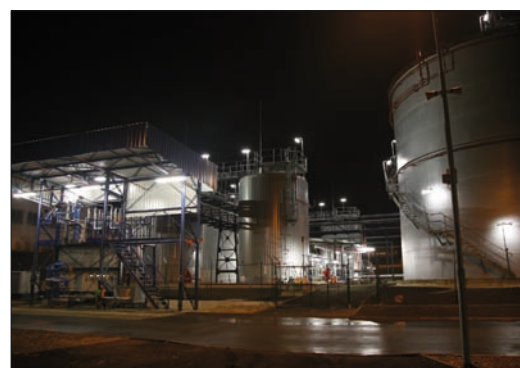
Obr. 2. Provozní soubor Sklad a stáčení biolihu – stáček místo pro autocisterny (foto Chemoprag)
