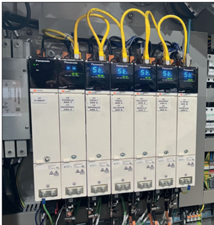
Obr. 4. Stroj je vybaven servopohony Minas A6 Multi
