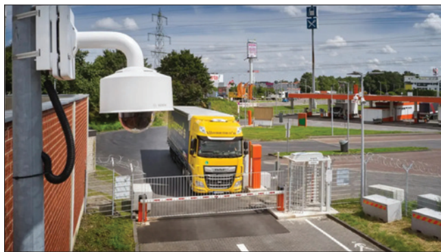
Obr. 3. Zabezpečené parkoviště pro kamiony Frechen nedaleko Kolína na Rýně je vybaveno technikou Bosch; řidič si ve zhruba stovce podobných areálů může rezervovat parkovací místo pomocí aplikace Secure Truck Parking
