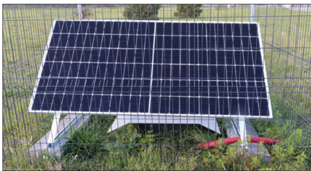
Obr. 4. Solární napájecí systém s vykrývacím akumulátorem dokáže bez problémů napájet detektor ROW a bránu GSM po celý rok
