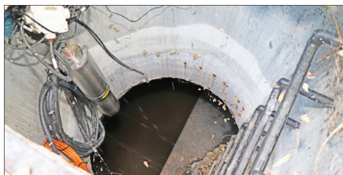
Obr. 3. Instalace detektoru ROW v provedení do prostředí s nebezpečím výbuchu ve skruži kanalizačního sběrače
