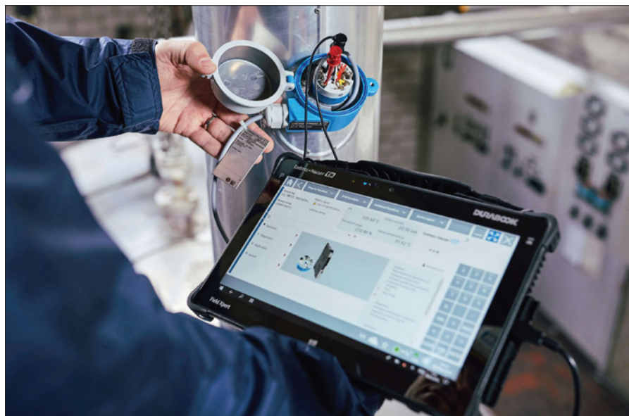
Obr. 4. Přehled o nainstalovaných přístrojích lze zobrazit na stolním počítači nebo v mobilním zařízení, např. na průmyslovém tabletu a komunikátoru HART Field Xpert SMT70
