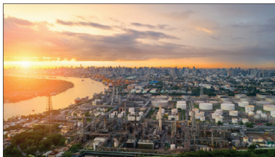
Obr. 1. Moderní závody obsahují stovky nebo tisíce měřících a kontrolních přístrojů
