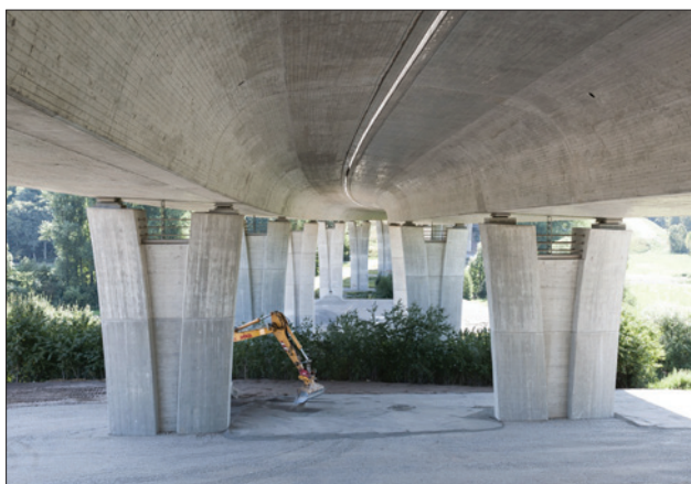
Obr. 2. V módu přesně odrážejícím aktuální stav složitého stavebního díla – při použití nové bezdotykové měřicí metody vyvíjené v KIT tak lze včas a při minimálních nákladech odhalit závady na mostní konstrukci (foto: Markus Breig)
