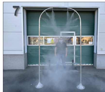
Obr. 2. Rámy ke zvlhčování vzduchu je možné v případě epidemie snadno upravit pro dezinfikování při vstupu do obchodních center, nádraží nebo úřadů
