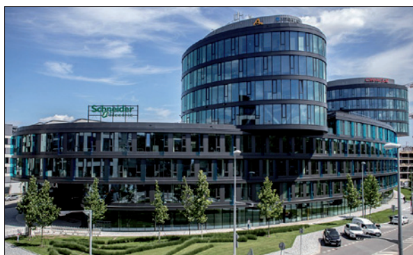
Obr. 1. Oracle Czech sídlí v moderních budovách, které byly postaveny v areálu bývalé Walthrovky v Praze-Jinonicích
