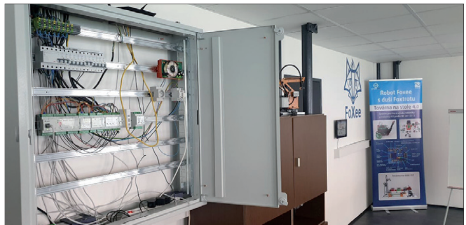
Obr. 4. Z pohledu do rozváděče je patrné, že Foxee Lab je řešen jako „chytrý dům“ – tato technika může být předmětem výuky i praxe
