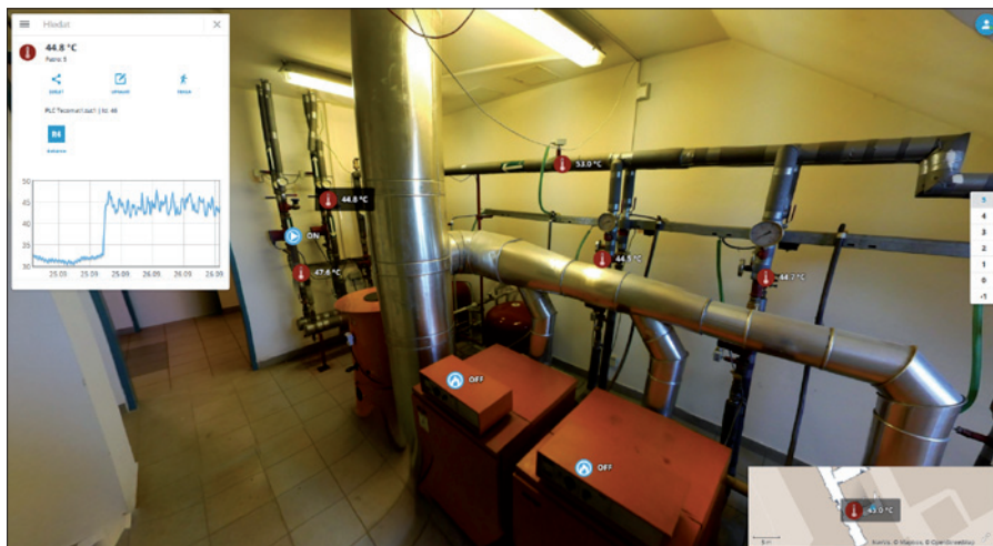
Obr. 3. 3D kotelna s živými hodnotami
