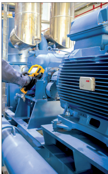
Obr. 1. Snímače ABB Smart Sensor přenášejí údaje bezdrátově prostřednictvím Bluetoothu
