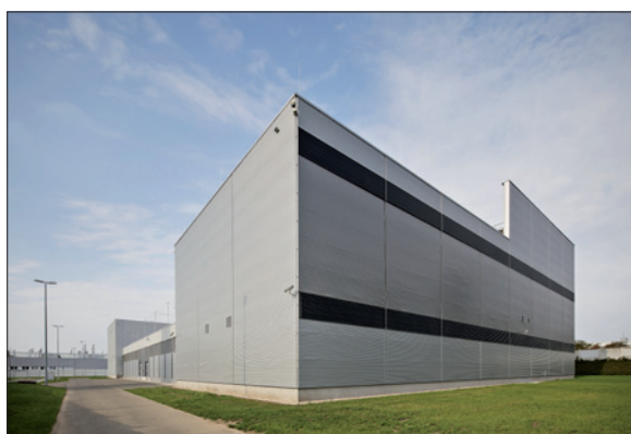
Obr. 1. Budova nového datového centra Škoda Auto
