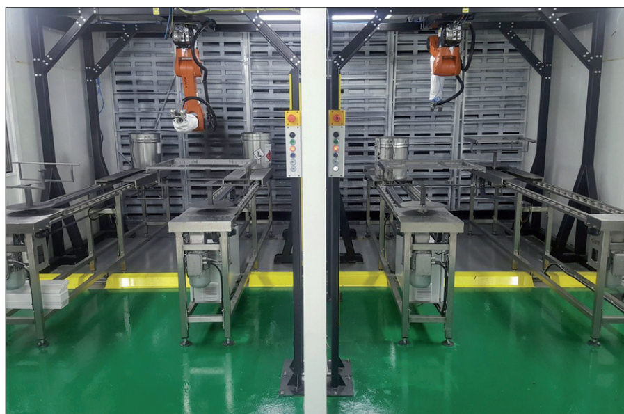
Obr. 1. Roboty KR Agilus jsou v lakovacím boxu upevněny na strop
