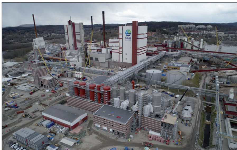
Obr. 1. Přestavba celulózky SCA v Östrandu je jednou z největších současných průmyslových investic ve Švédsku
