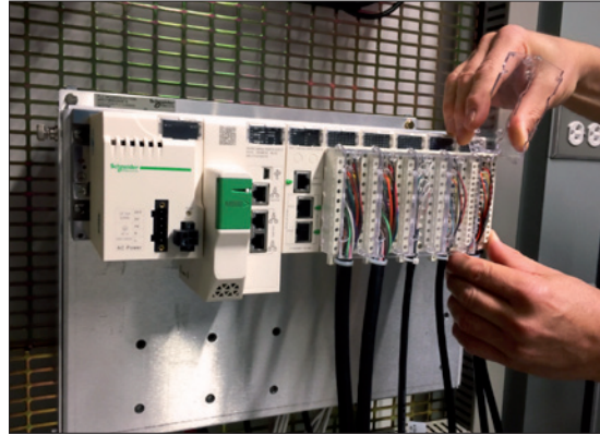
Obr. 4. Do systému M580 je možné doplňovat I/O jednotky a vyměňovat je za běhu
