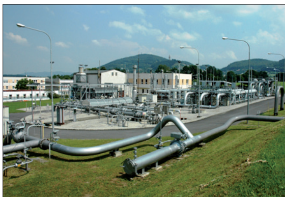
Obr. 2. Podzemní zásobník plynu Štramberk
