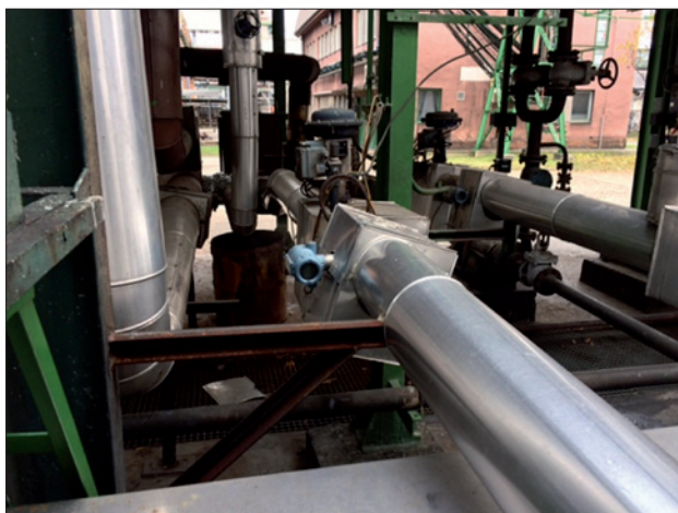
Obr. 7. Vírový průtokoměr Rosemount 8800 instalovaný v rafinerii DEZA na měření antracénového oleje – spolehlivý provoz pět let bez údržby
