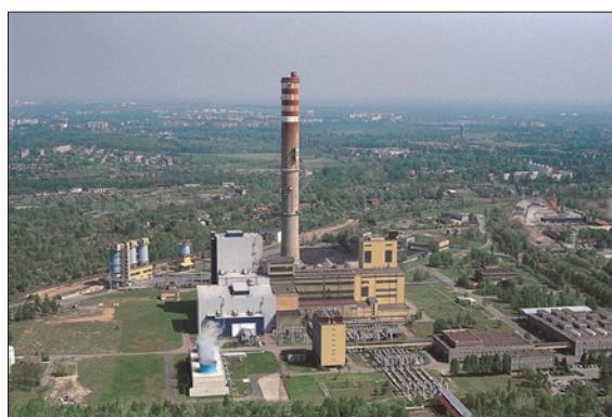
Obr. 1. Distribuovaný řídicí systém SandRA dodá společností ZAT do teplárny EC Katowice
