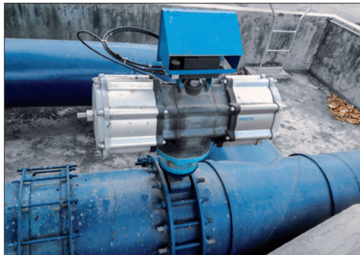
Obr. 1. Regulační ventil ovládaný čtvrtotáčkovým pneumatickým pohonem DAPS 8000
