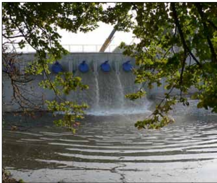
Obr. 1. Pohled od Vltavy na hráz uzávěru, čerpadla 1 až 3 jsou v chodu
