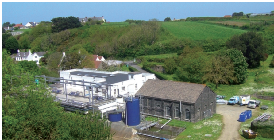
Obr. 1. Nově zřízená úpravná vody neměla telefonní linku
